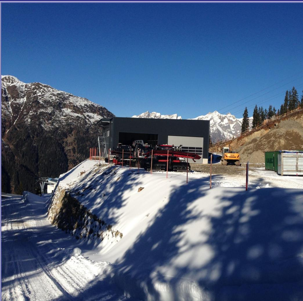
Für die Errichtung dieser Fläche mussten rund 10.000 m<sup>3</sup> Fels gesprengt werden (Bild: BB See)
